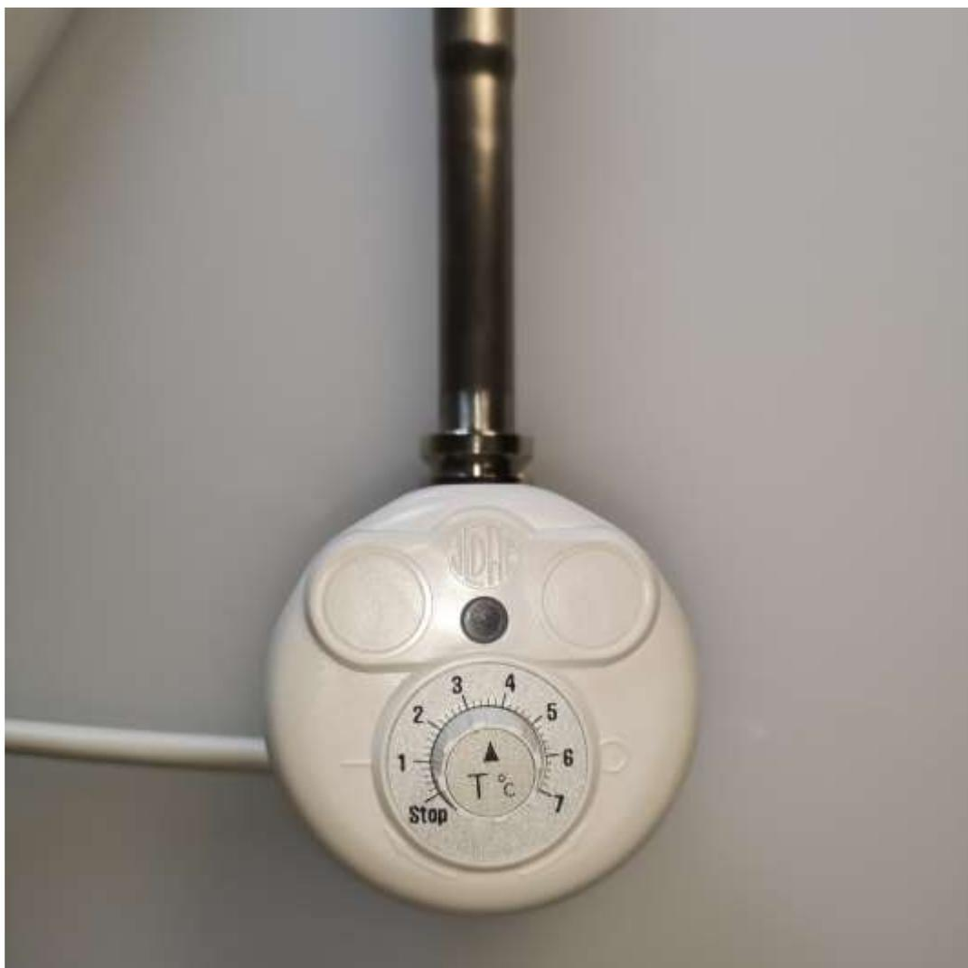
Le modèle Ths JHAI est destiné à l'équipement d'un radiateur raccordé à un réseau de chauffage central ou indépendant de tout réseau. L'insert chauffant doit être monté en position horizontale dans le collecteur bas du radiateur. Le raccord laiton 1/2 » doit être vissé directement dans le radiateur.
